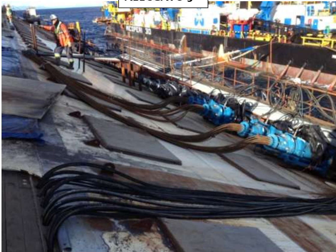
Sopra: Tensionamento cavi di ritenuta su murata sinistra Costa Concordia Sotto: Malaviya 20 ormeggiato a fianco del Pioneer.
