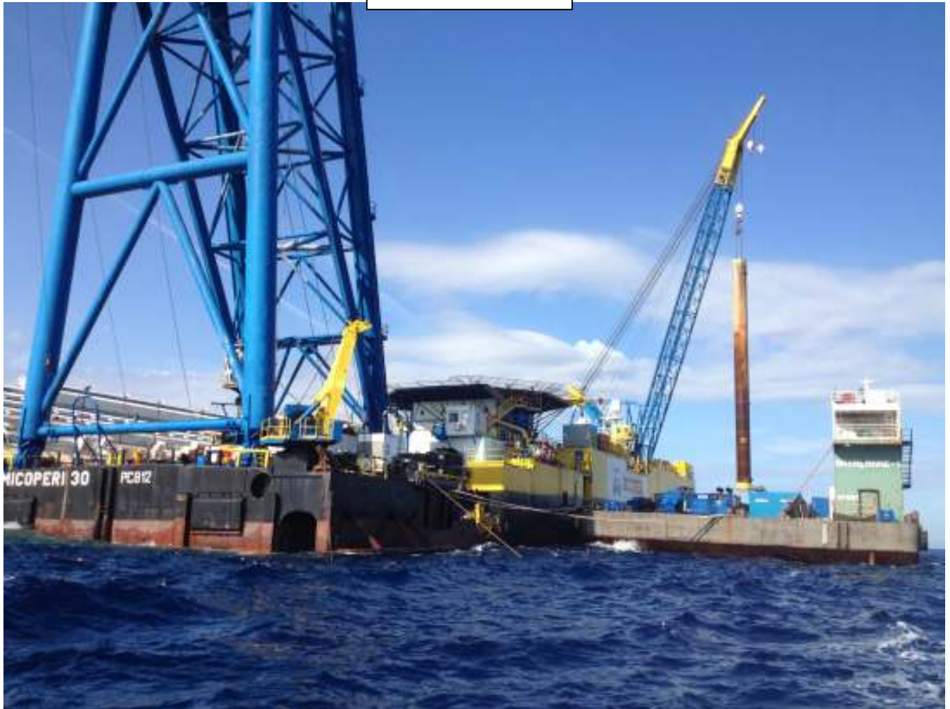
Movimentazione casing al termine delle trivellazioni per la piattaforma 6.
