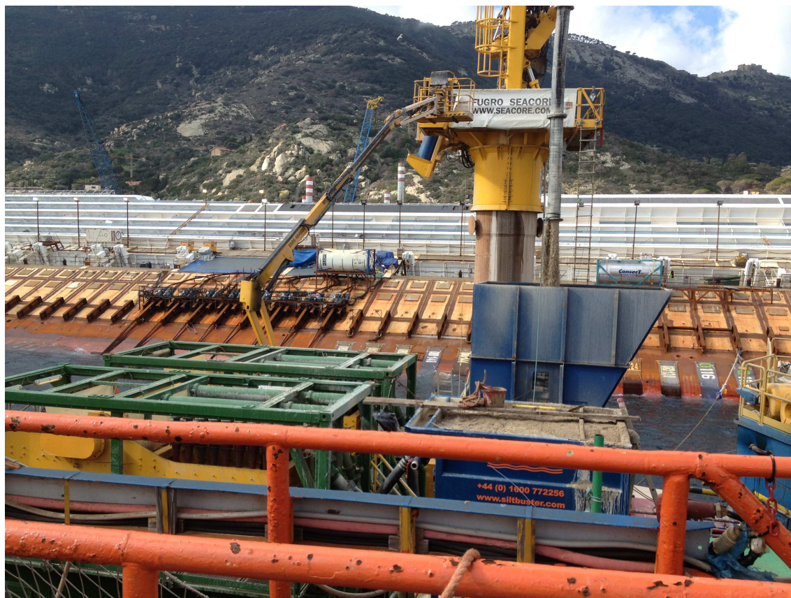
Sopra: Trivellazione in corso sul foro DH6
