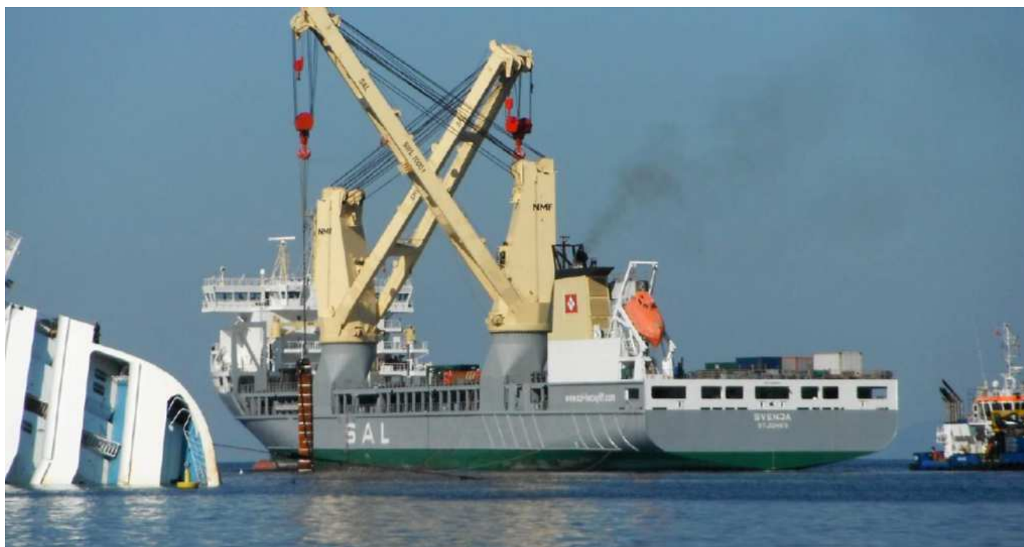
Operazioni di installazione sul fondale dei pali DH2, DH4 e DH6 della piattaforma 1
