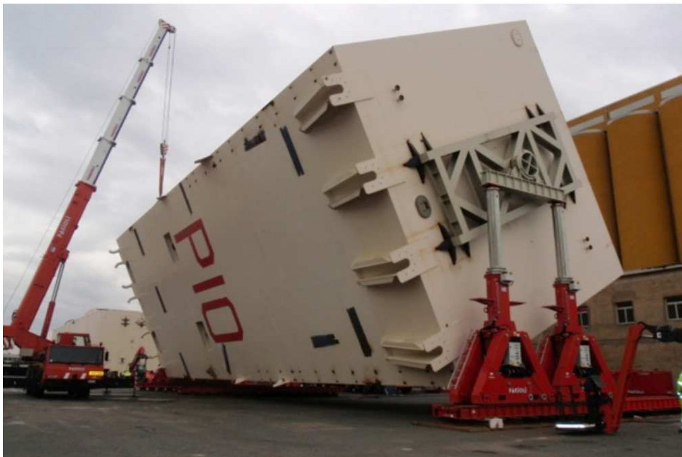
Operazioni di rotazione del cassone P10 presso Livorno Condizioni meteo marine avverse
