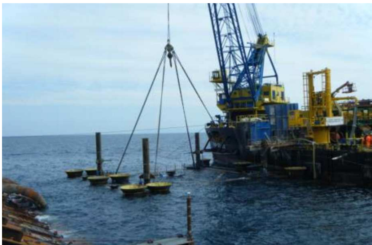
M/V Svenja e pontone Micourier 1 con Piattaforme a P S Stefano in preparazione per l'installazione Operazioni di posizionamento dima per piattaforma 2
