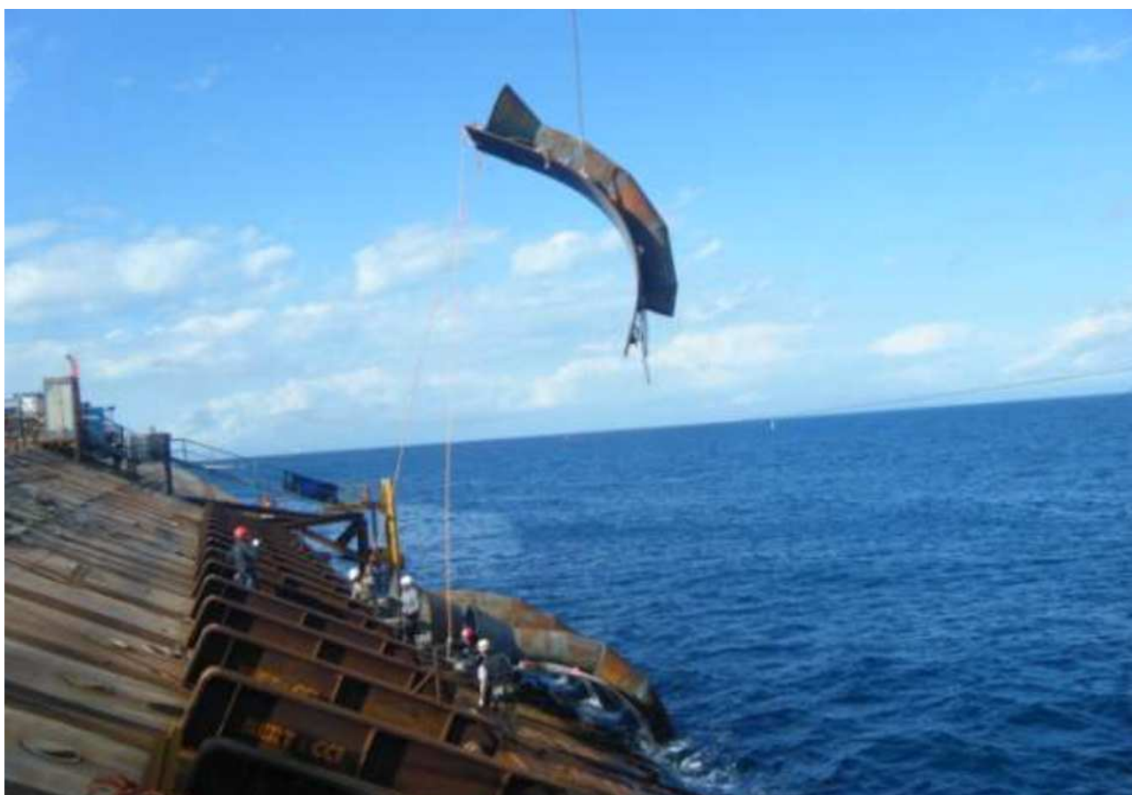
Installazione bilge plates sulla fiancata sinistra della Costa Concordia
