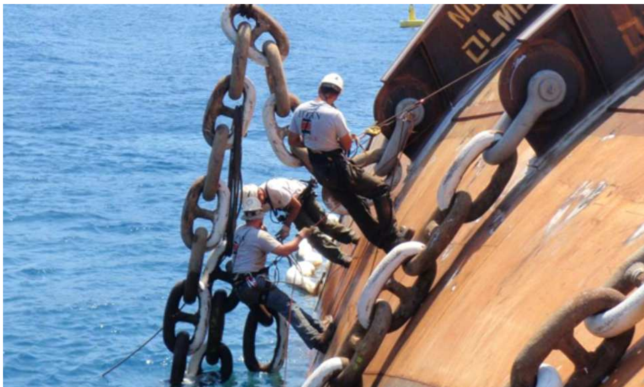
Sopra: installazione catene per sistema di ritenuta Sotto: Sollevamento cassone di spinta PO3 sulla M/N SAL Lone
