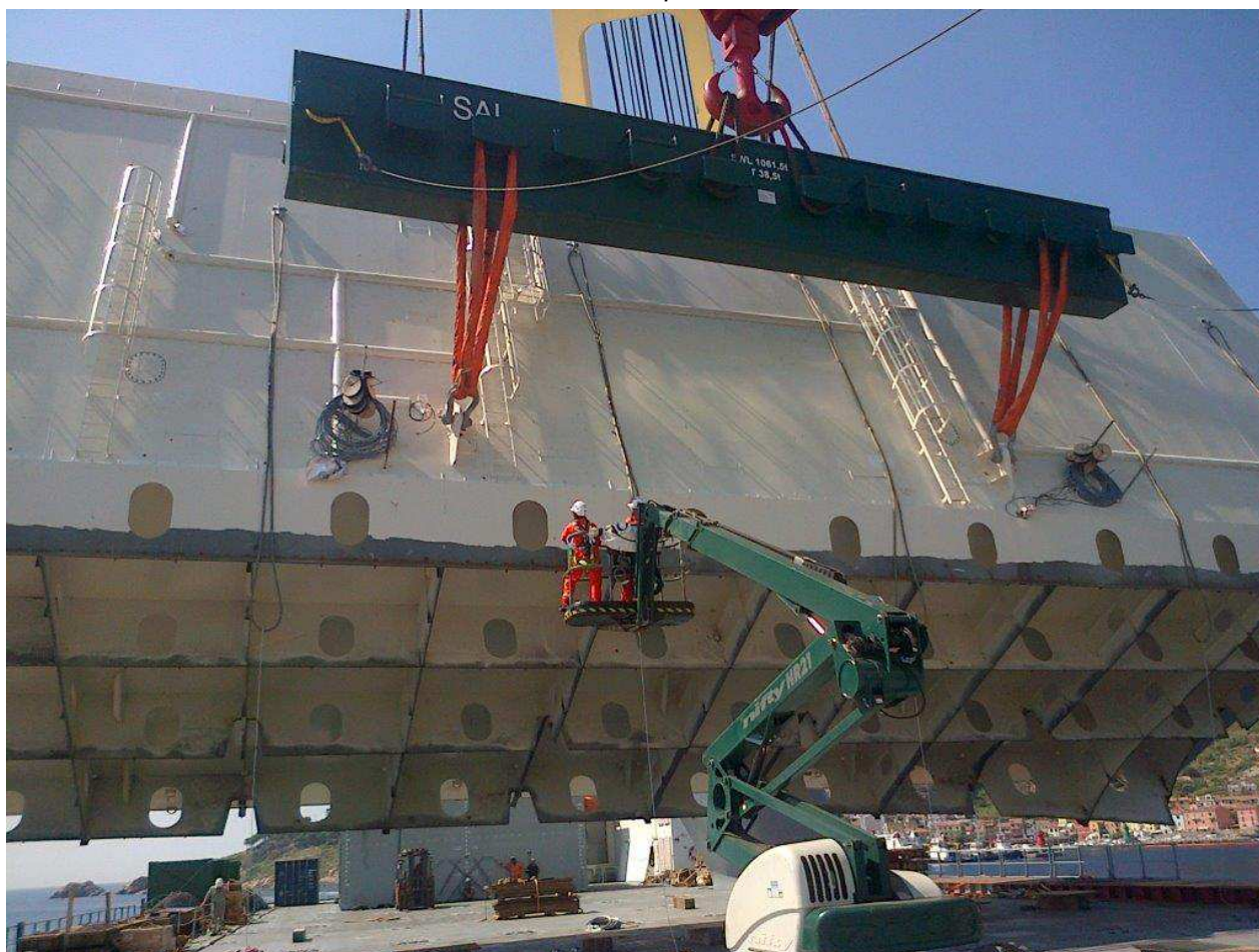
Sopra: installazione catene per sistema di ritenuta Sotto: Sollevamento cassone di spinta PO3 sulla M/N SAL Lone
