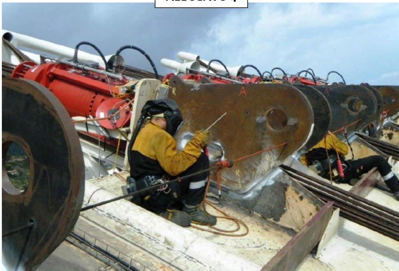
Sopra: Saldatura Basi per martinetti (Cheek Plates) installati sopra i cassoni di spinta Sotto: Veduta aerea
