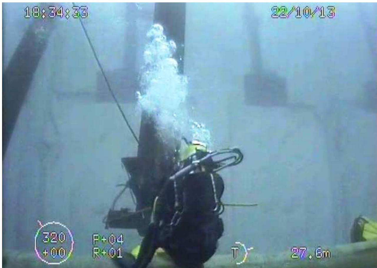
Sopra: Operazioni di installazione supporto tubolare Sotto: cassoni a Palermo a bordo del Pontone Micourier 1 per trasferimento a Livorno
