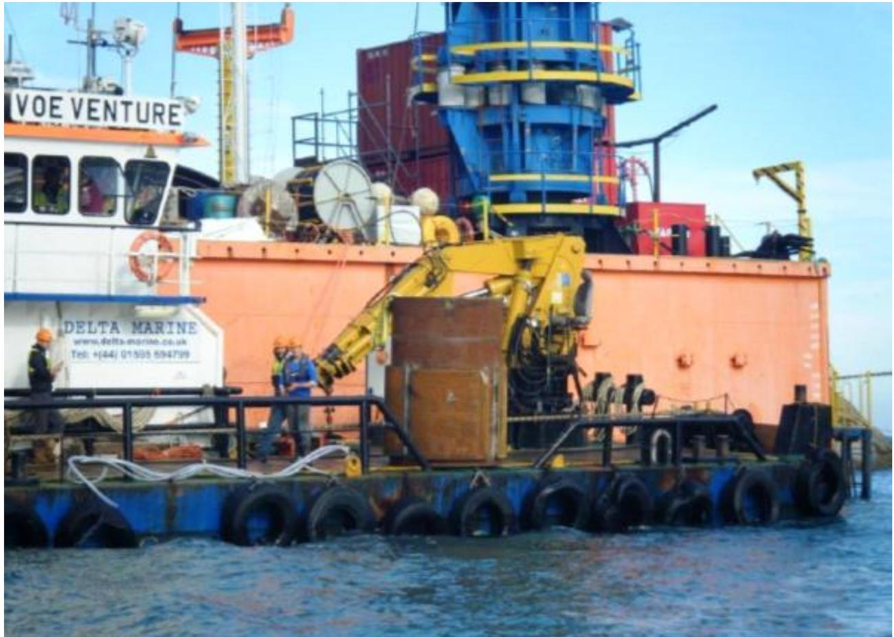
*Sopra: Posizionamento corpi morti in preparazione ad installazione sistema di ritenuta di prua
