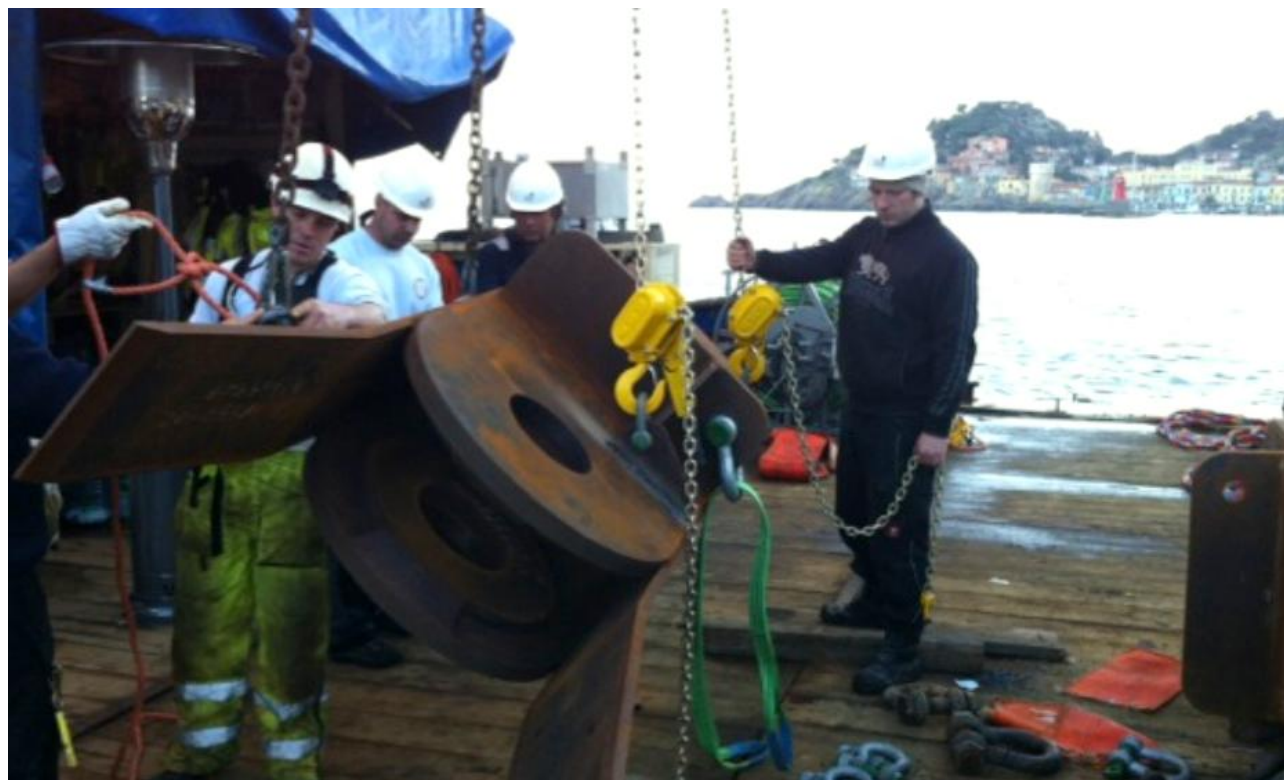
Operazioni di installazione sistema di ritenuta di prua
