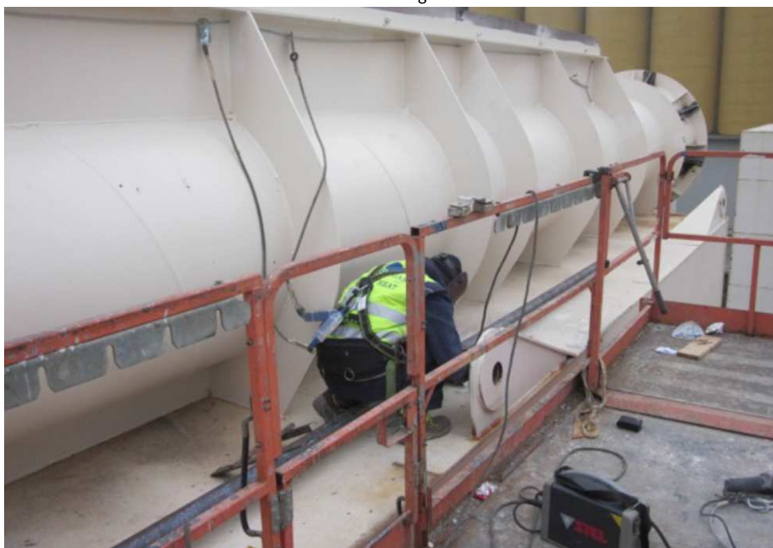
Sotto: installazione tubi guida sui cassoni
