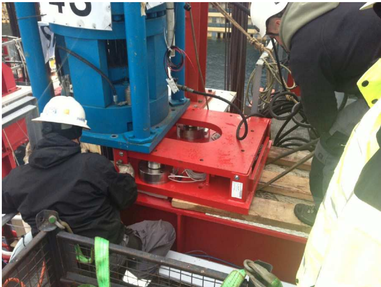
Installazione cella di carico
