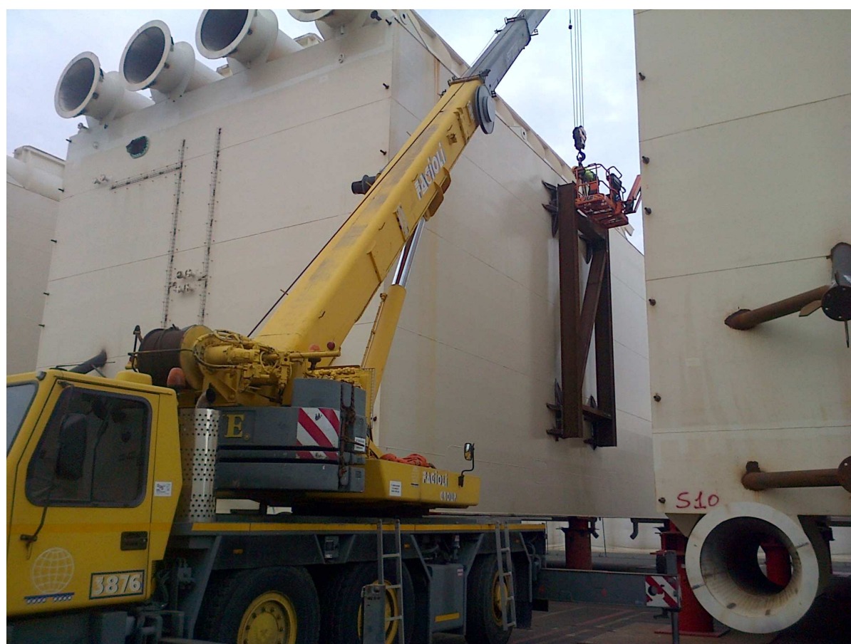
Installazione supporti per la rotazione dei cassoni
