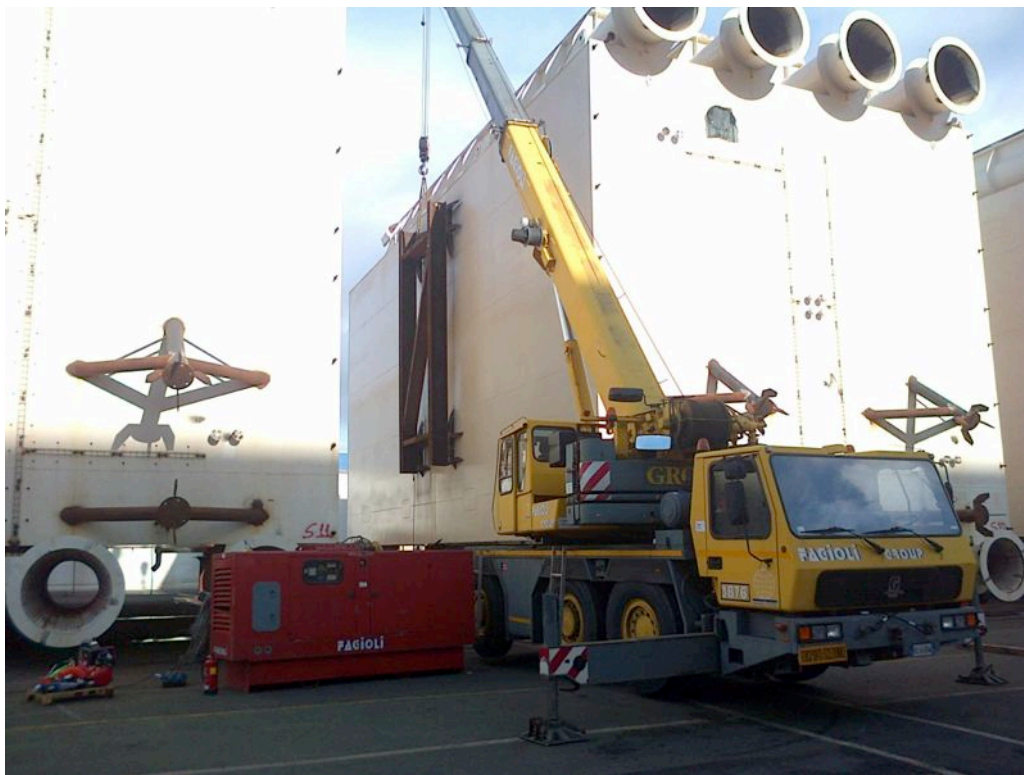
Installazione supporti per la rotazione sul cassone S10 Sotto: riavvio attività nel cantiere di Livorno
