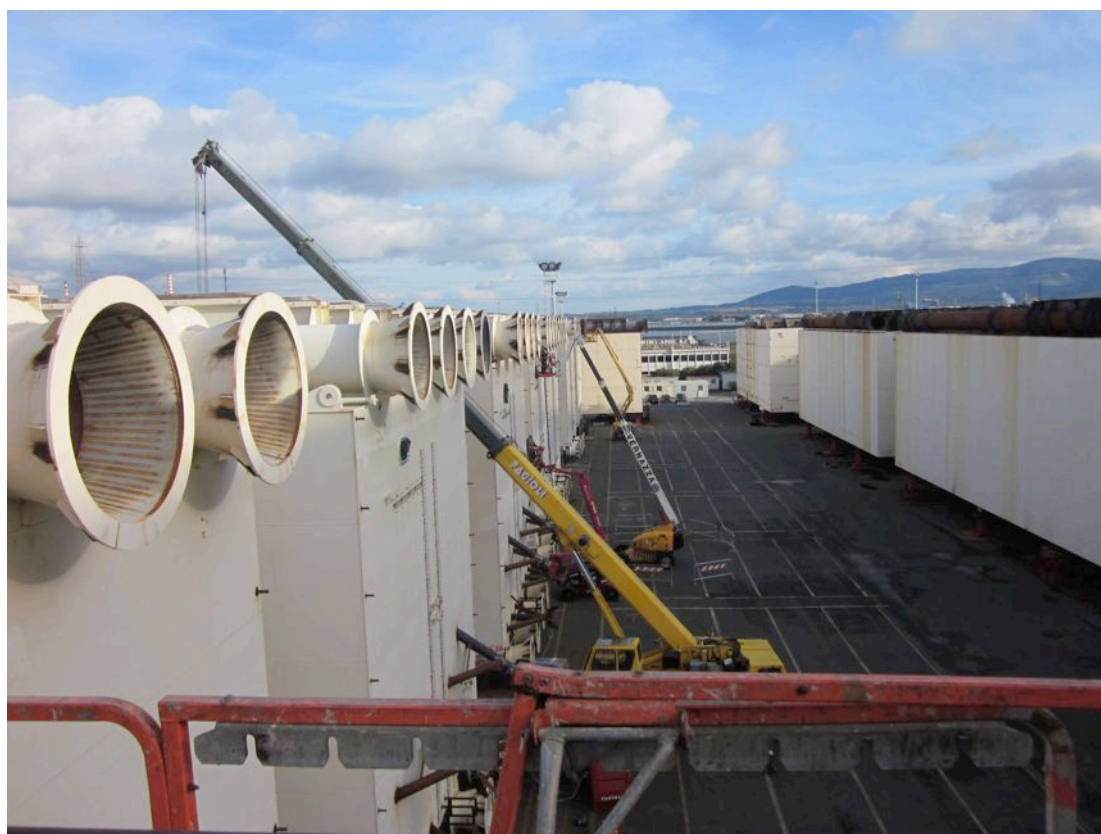
Installazione supporti per la rotazione sul cassone S10 Sotto: riavvio attività nel cantiere di Livorno
