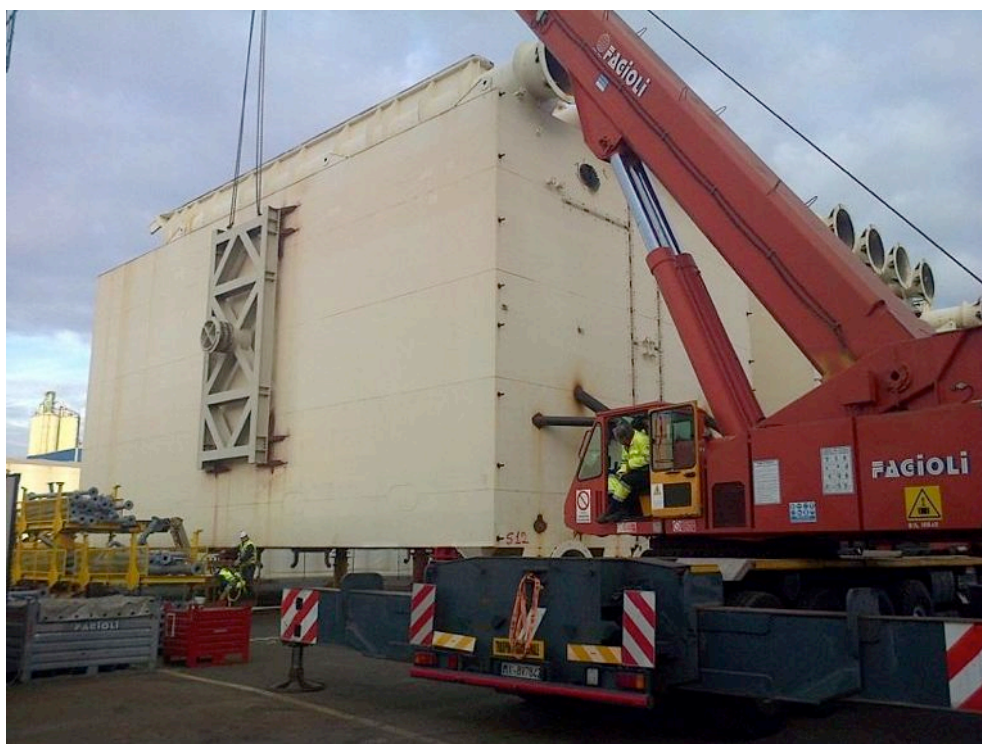
Sopra: Installazione telaio per la rotazione sul cassone di spinta S12 Sotto: Preparazione del cassone di spinta S12 per la rotazione
