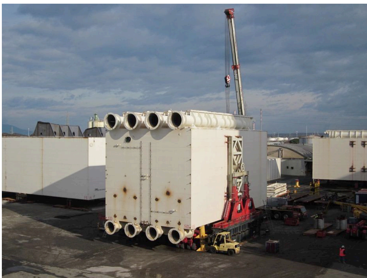
Sopra: Installazione telaio per la rotazione sul cassone di spinta S12 Sotto: Preparazione del cassone di spinta S12 per la rotazione
