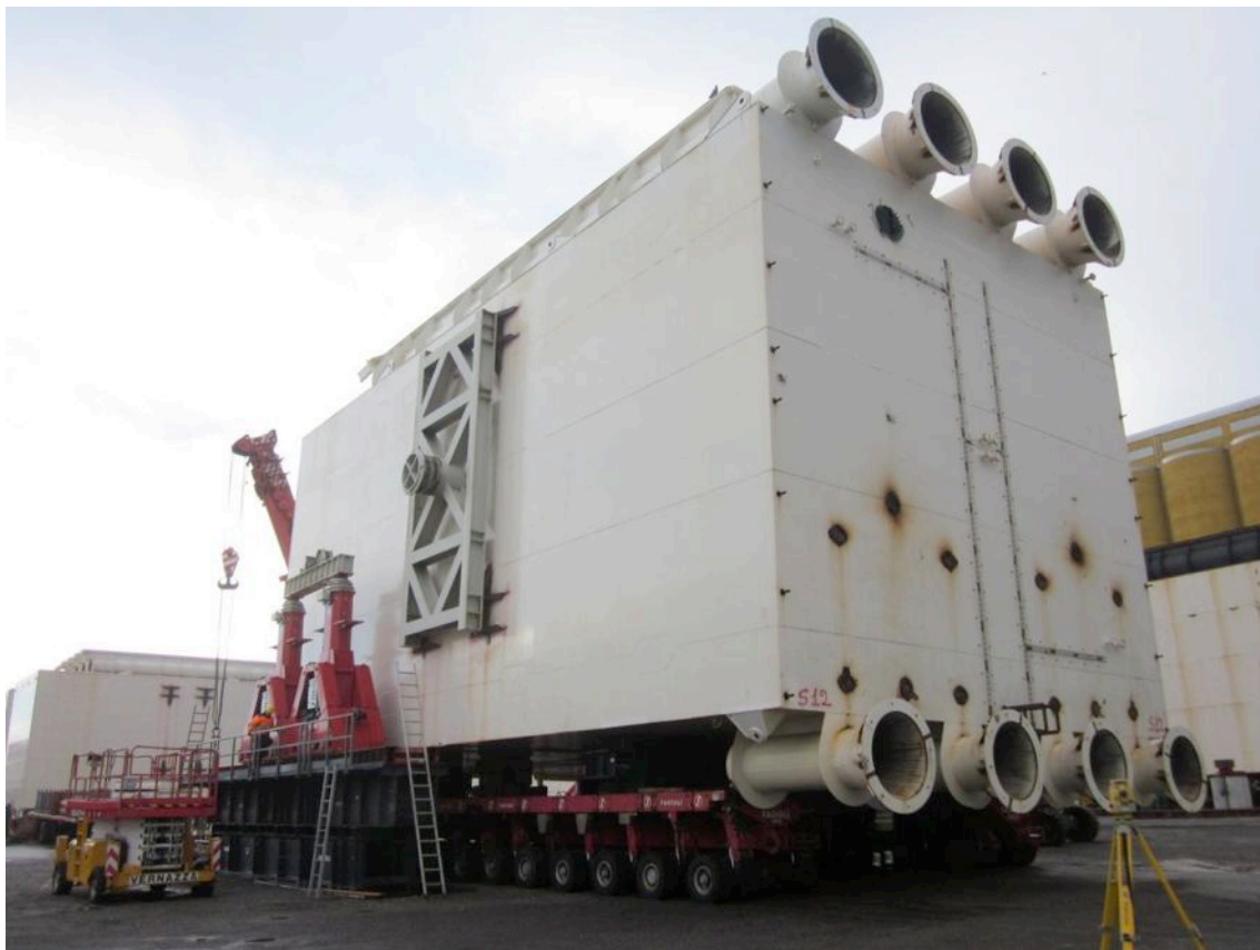
Preparazione del cassone di spinta S12 per la rotazione
