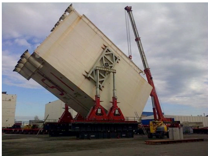
Rotazione cassone di spinta S11 presso il cantiere di Livorno
