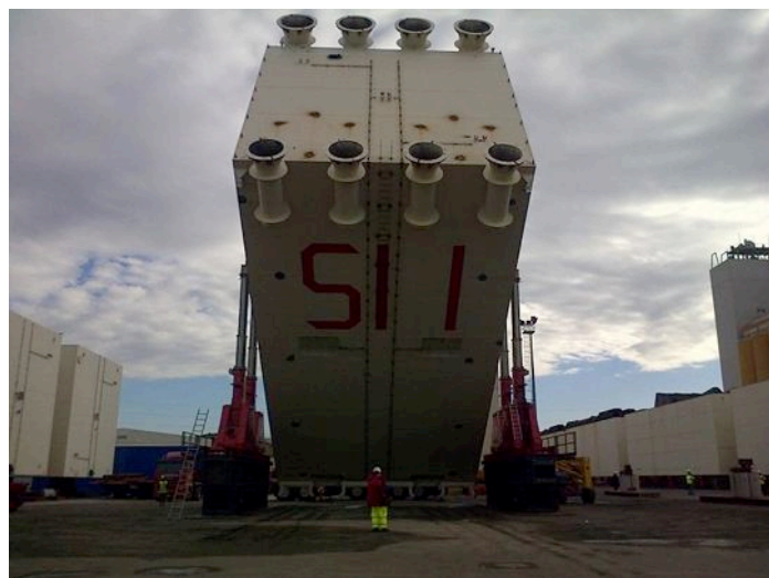
Rotazione cassone di spinta S11 presso il cantiere di Livorno
