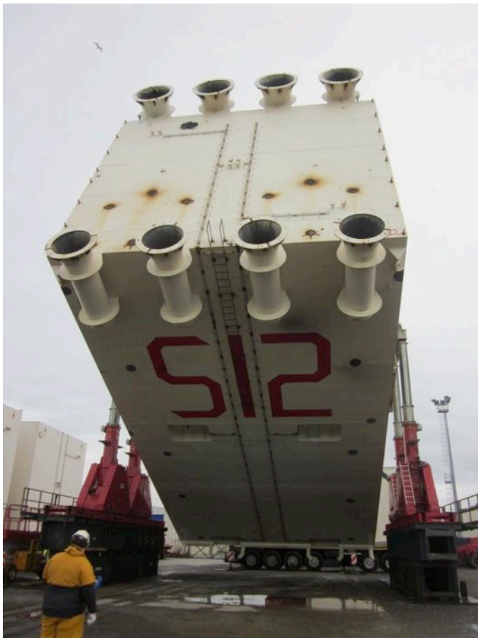
Rotazione del cassone di spinta S12 presso il cantiere di Livorno
