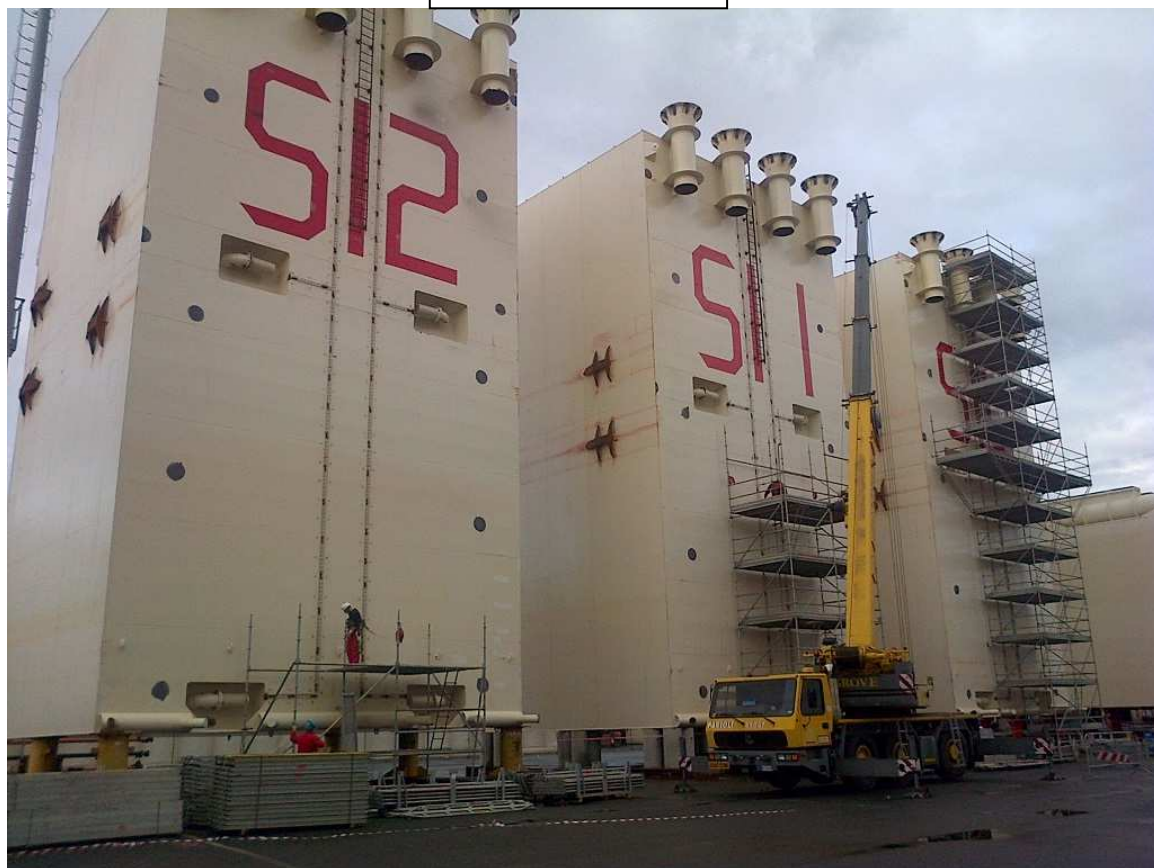
Installazione impalcature sui cassoni di spinta
