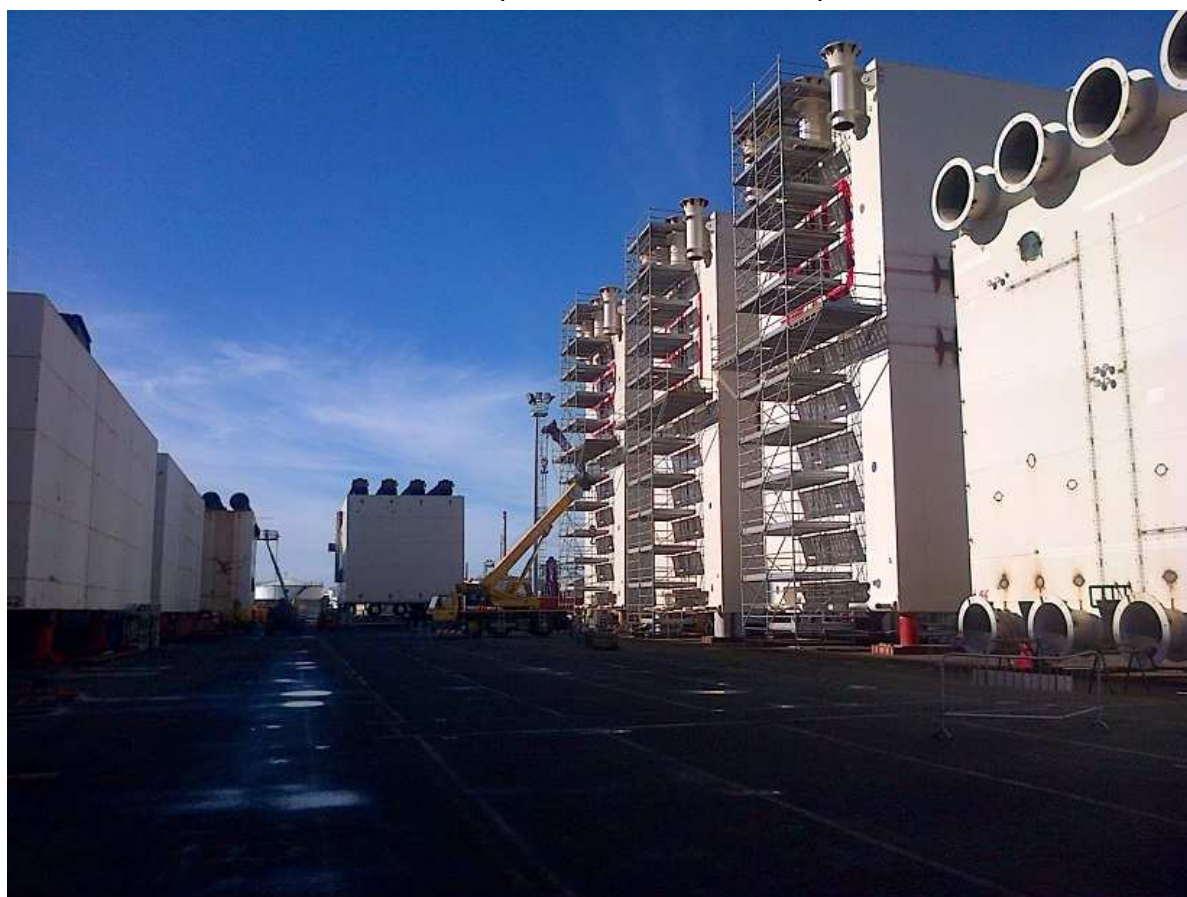
Installazione impalcature sui cassoni di spinta
