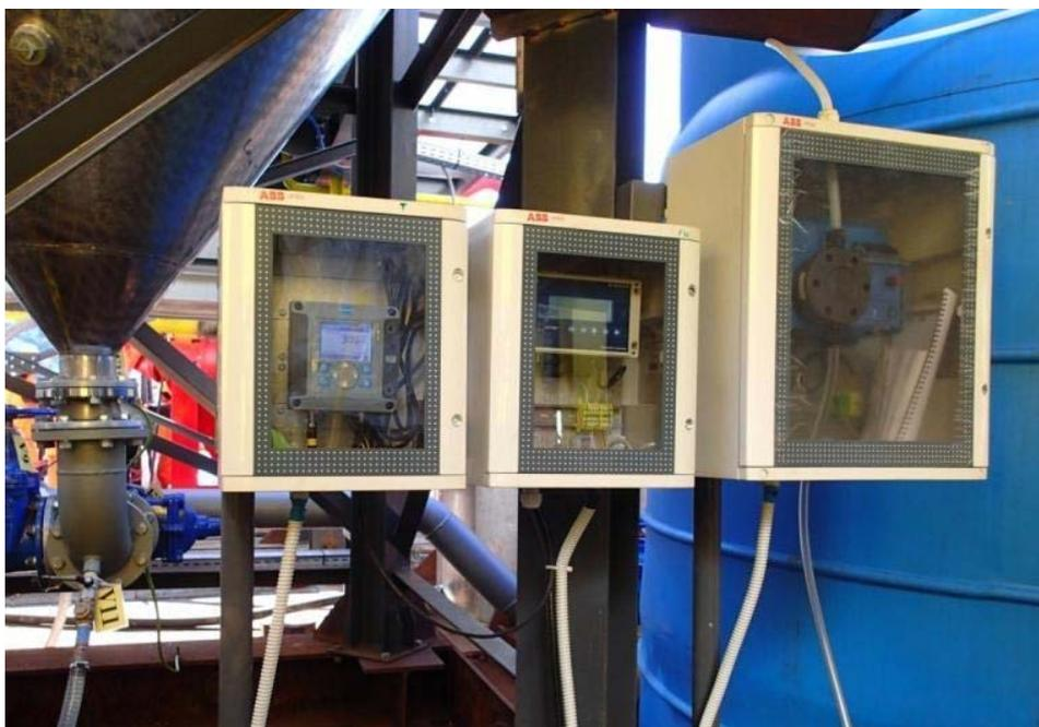
Il sistema automatico di controllo della qualità dell'acqua in uscita (torbidità e pH).
