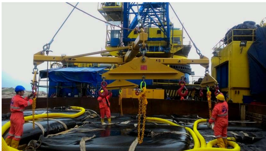
La fase di connessione delle fasce del geosacco ai ganci del bilancino durante lo svolgimento del test.
