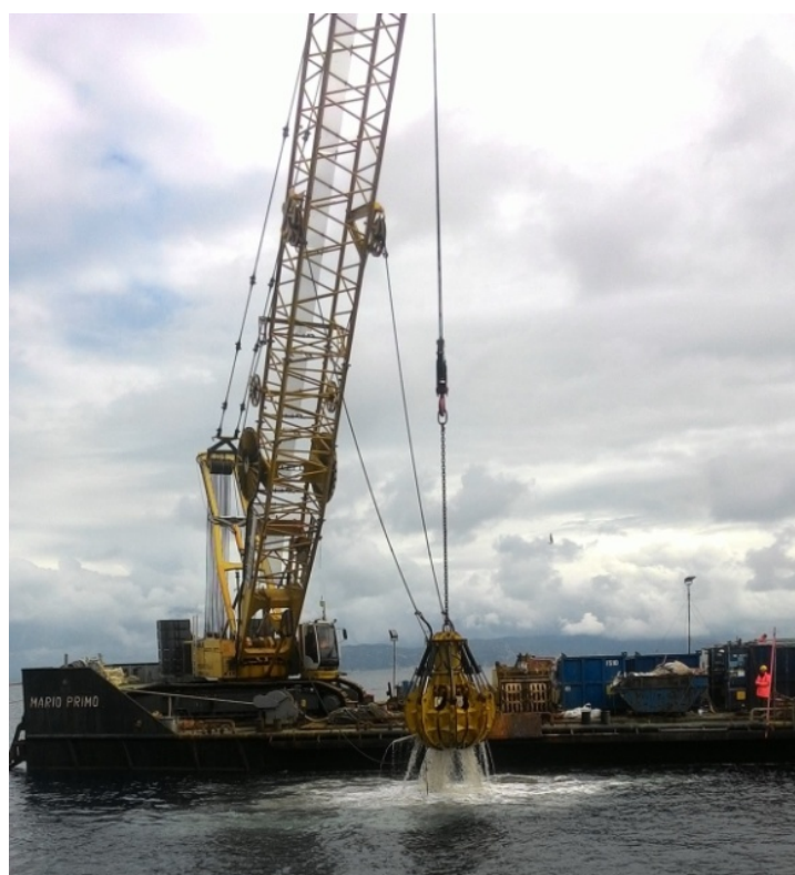
La benna impiegata per la rimozione dei debris
