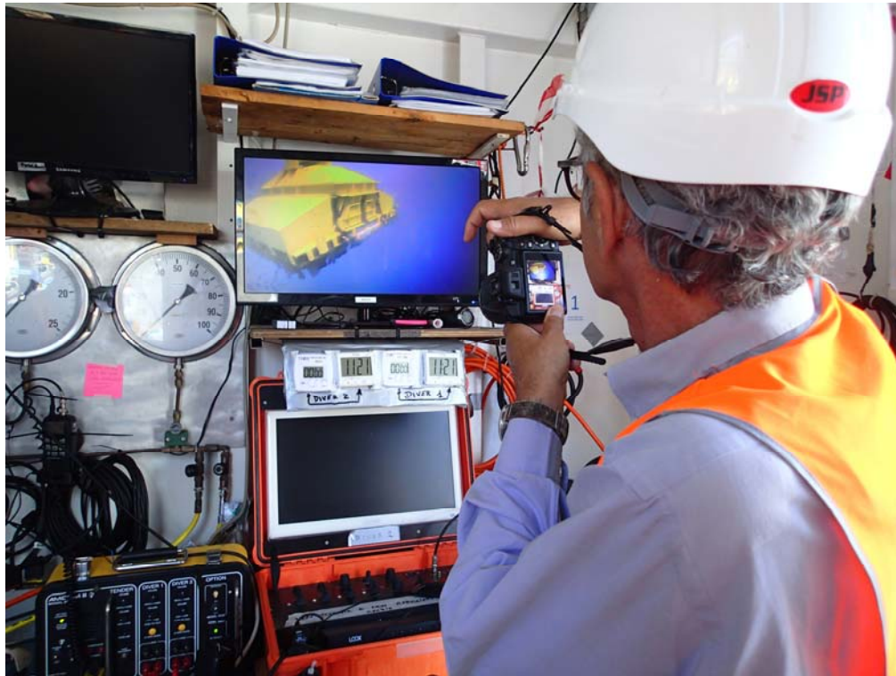
Verifica di funzionamento del sistema di frantumazione dei pezzi di cemento
