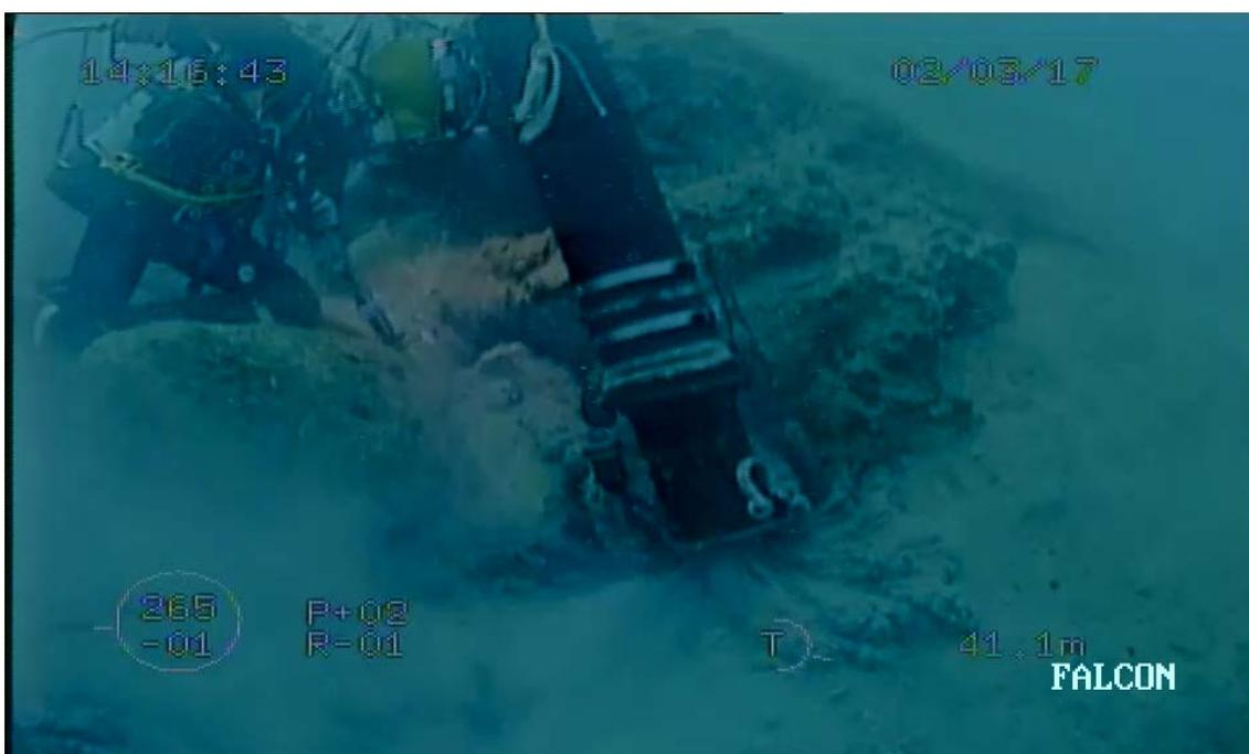
Operatore subacqueo con spingarda ad acqua ad elevata pressione e sorbona rimuove il sedimento dal fondale roccioso
