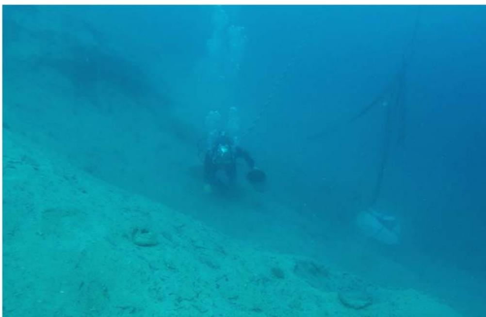
L'operatore subacqueo raccoglie a mano i pezzi di cemento rimasti dopo la sorbonatura.
