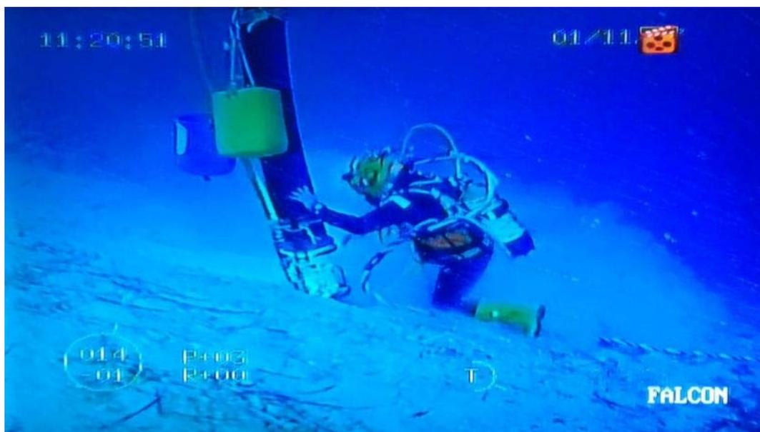
Aspirazione dei sedimenti mediante sorbona dai fondali dell'area DW-B.
