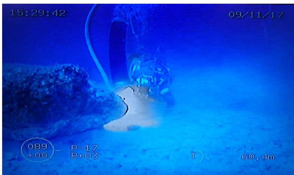
Diver operante con sorbona manuale in prossimità di un affioramento roccioso nell'area DW-B. Notare il segno di colore più chiaro sulla roccia che indicava il livello raggiunto dallo strato di sedimenti di natura cementizia, appena rimossi.
