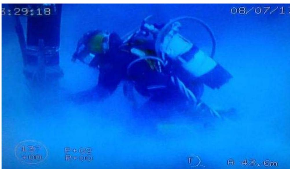
Il SAT diver in un momento dell'aspirazione dei sedimenti sul fondale dell'area WG-B.
