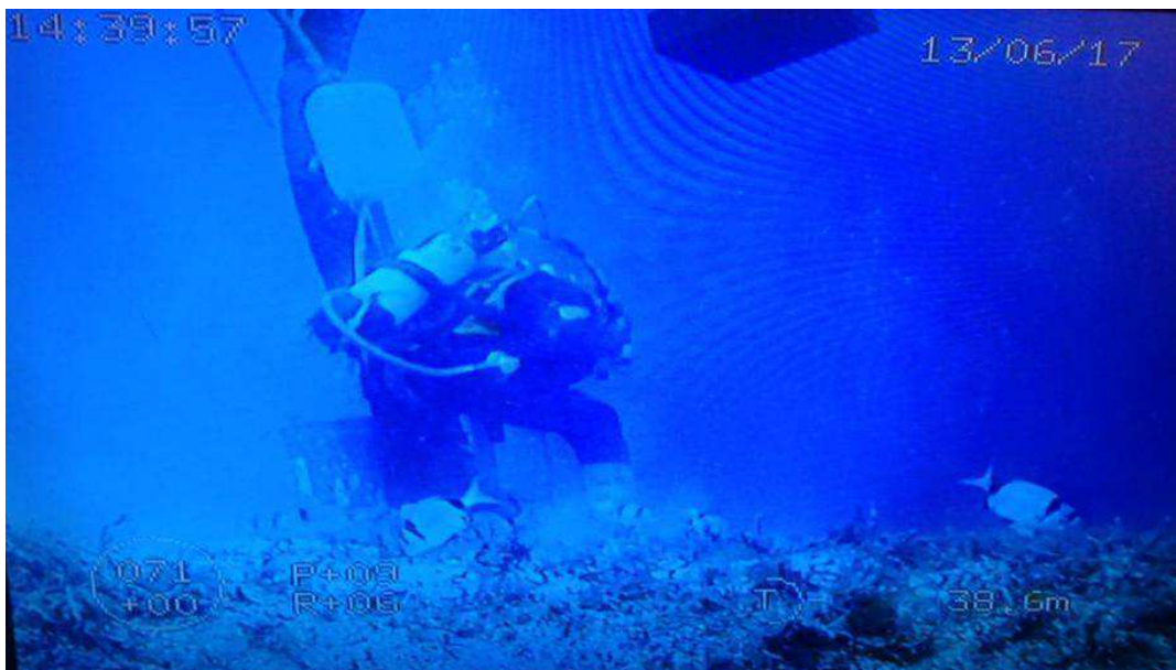
Una delle fasi di aspirazione mediante sorbona manovrata dal SAT diver Micoperi.
