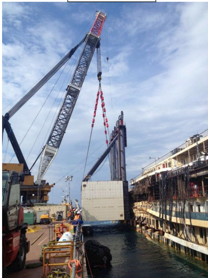
Sopra: installazione cassone di spinta S13.
