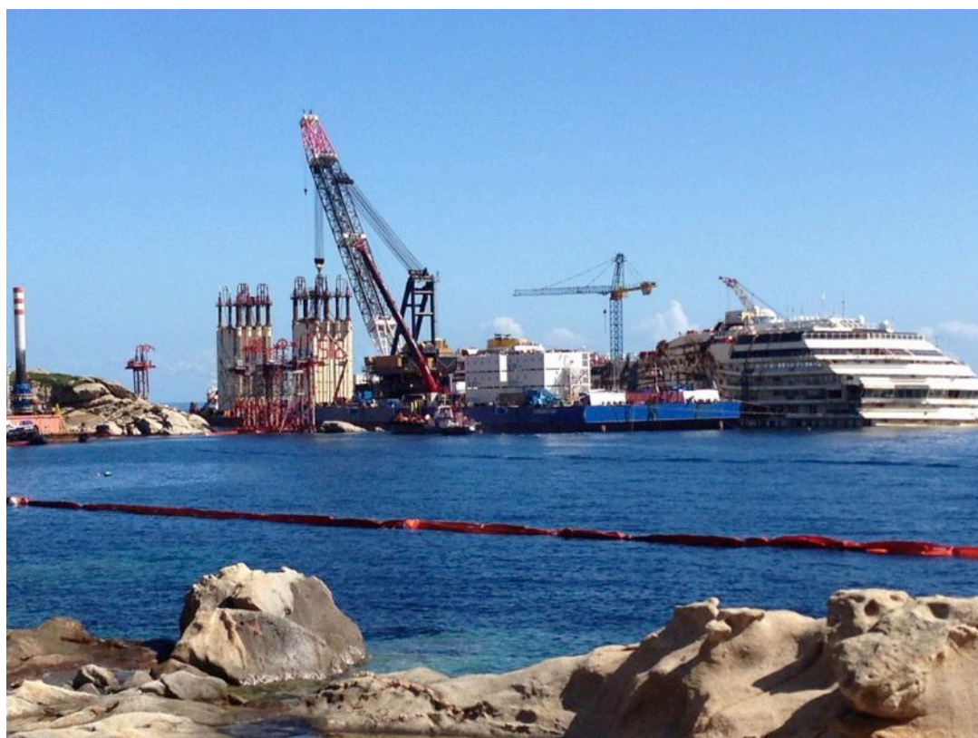
Sotto: operazioni di sollevamento del cassone S12
