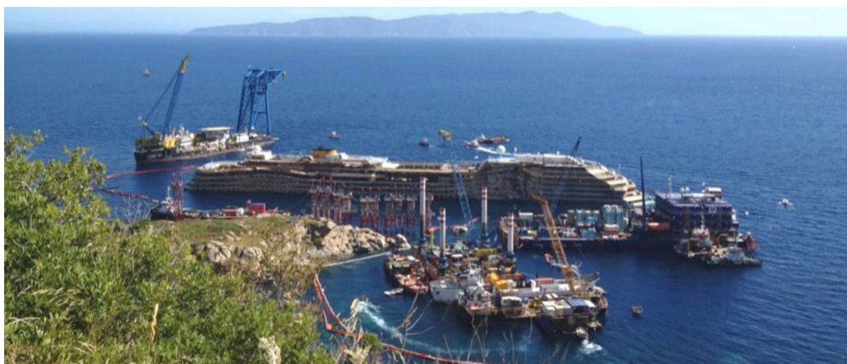
Figura 7. Postazione a terra per le attività di avvistamento cetacei (N 42° 21' 53.0" E 010° 55' 00.5")
