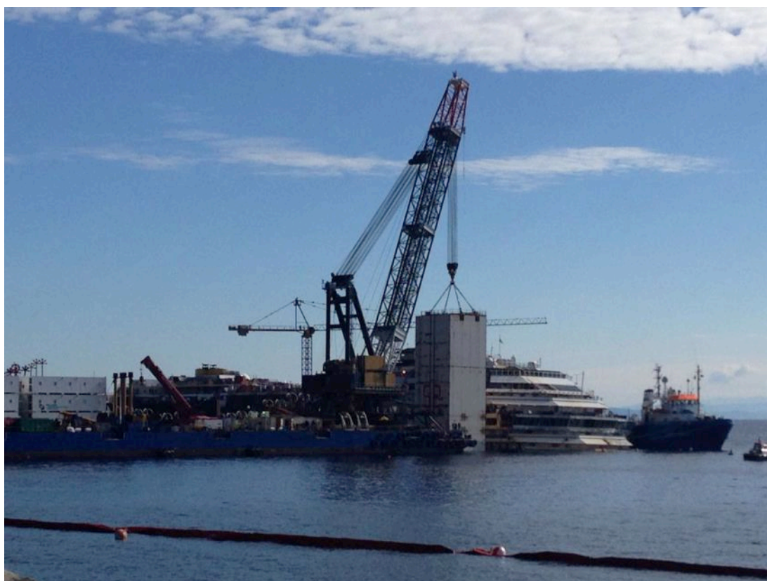
Sotto: installazione del cassone S2
