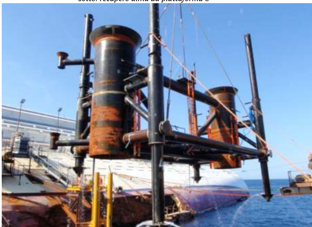
Sotto: recupero dima da piattaforma 6
