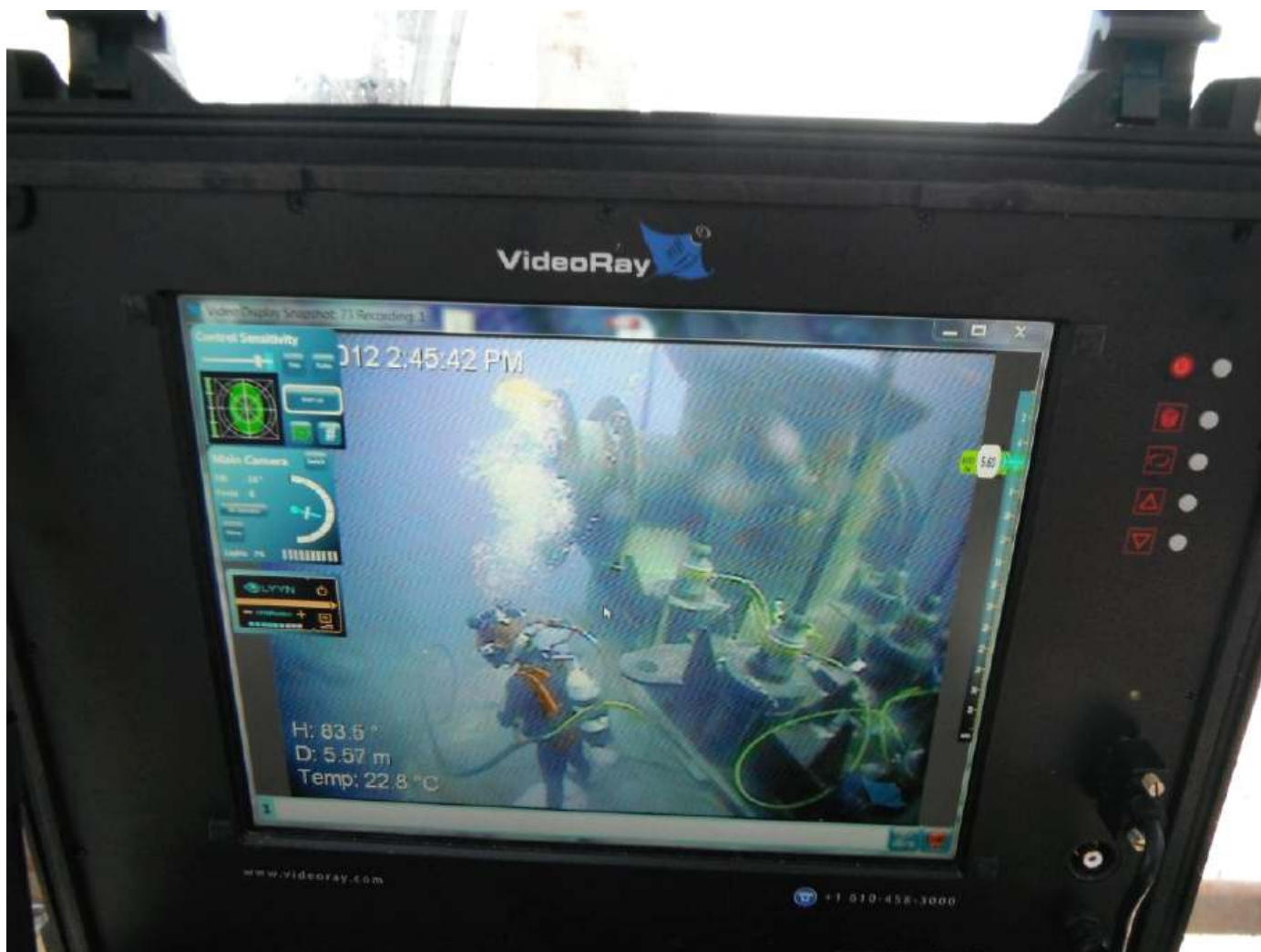
Sopra: attività di tensionamento micro-pali su anchor block.
