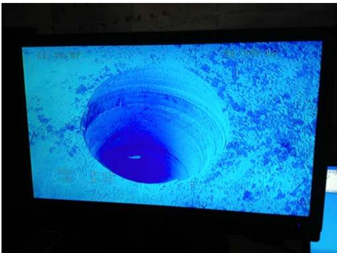
Sopra: completamento trivellazione foro per palo DH26
