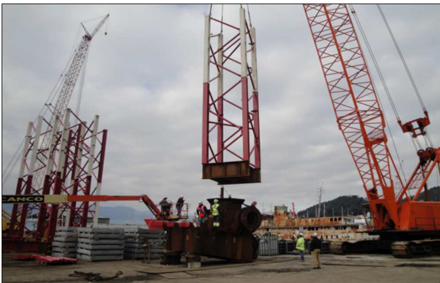
Sopra: operazioni di rimozione pittura sulla Costa Concordia. Sotto: test posizionamento torrette su anchor block
