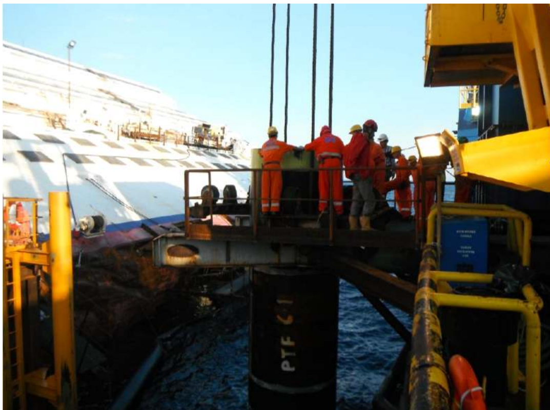
Sopra: posizionamento dima per piattaforma num. 6 (poppa) Sotto: posizionamento casing trivella.
