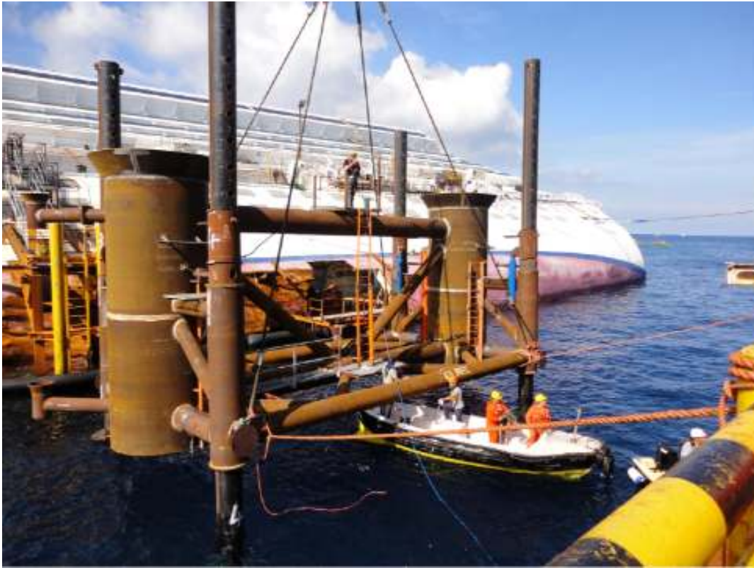
Sopra: posizionamento dima per piattaforma num. 6 (poppa) Sotto: posizionamento casing trivella.
