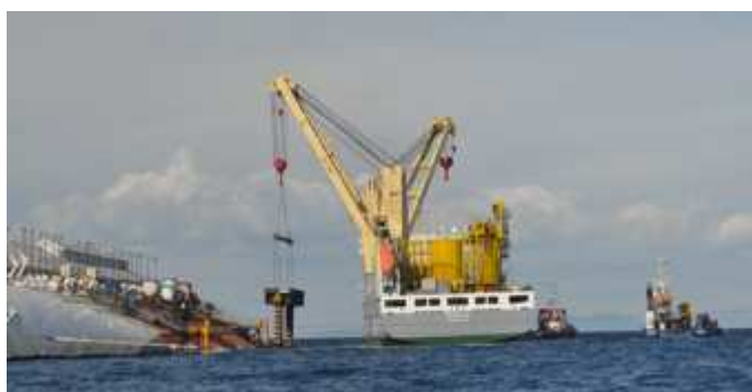
Figura 4. Lavori di posizionamento SAL
