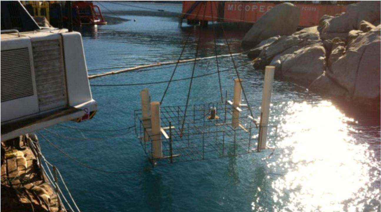
*Sopra: Prove di posizionamento sul fondale della intelaiatura di rinforzo per l'anchor block 8*
