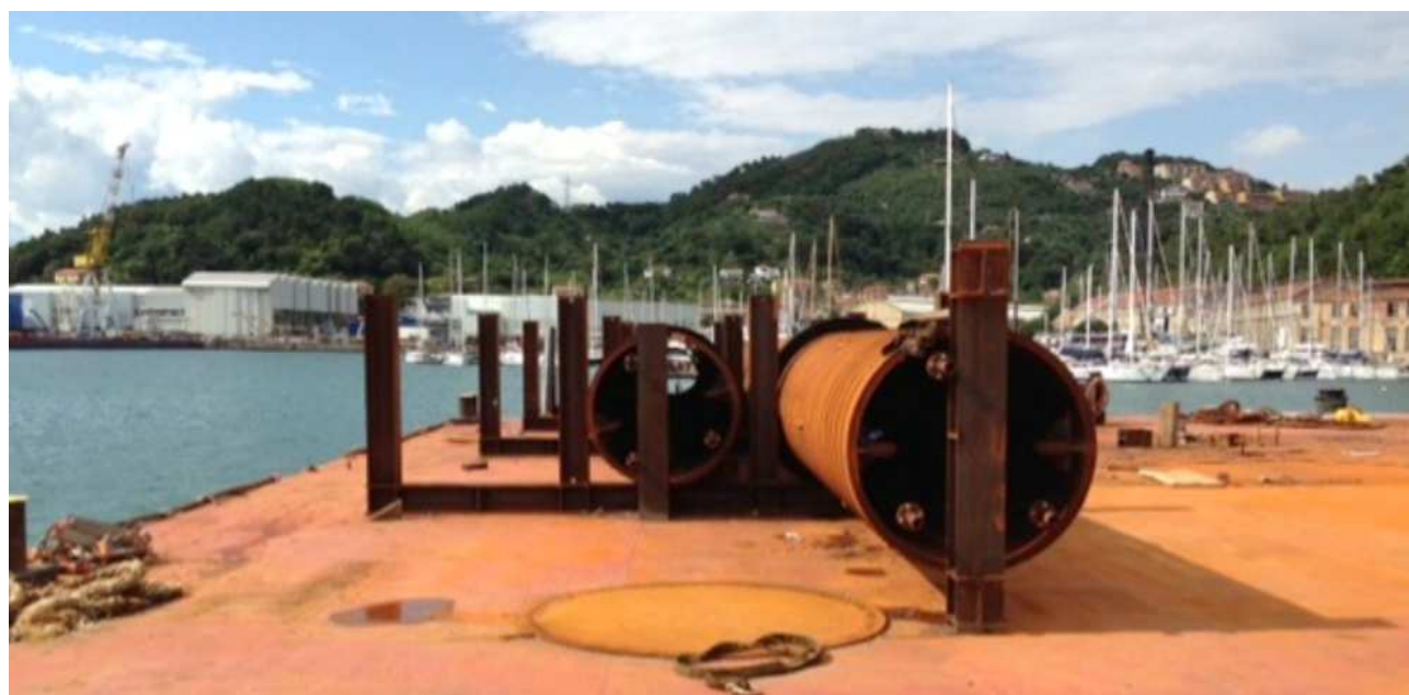
Sopra: torri con martinetti idraulici in area di lavoro Sotto: Pali DH7 e DH9 per piattaforma 2
