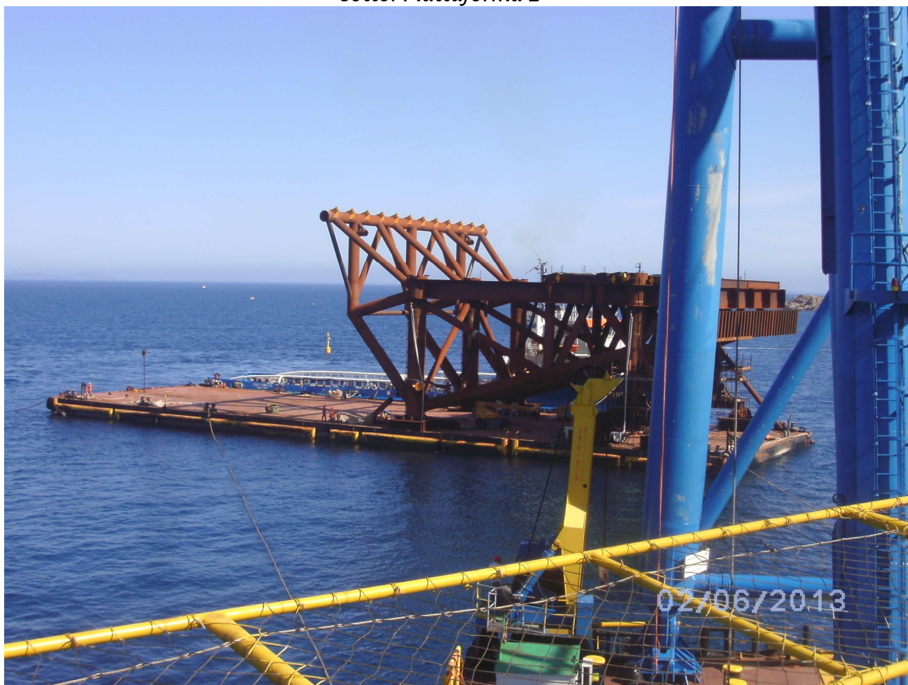
Sopra: Operazioni di installazione terza gash plate Sotto: Piattaforma 2
