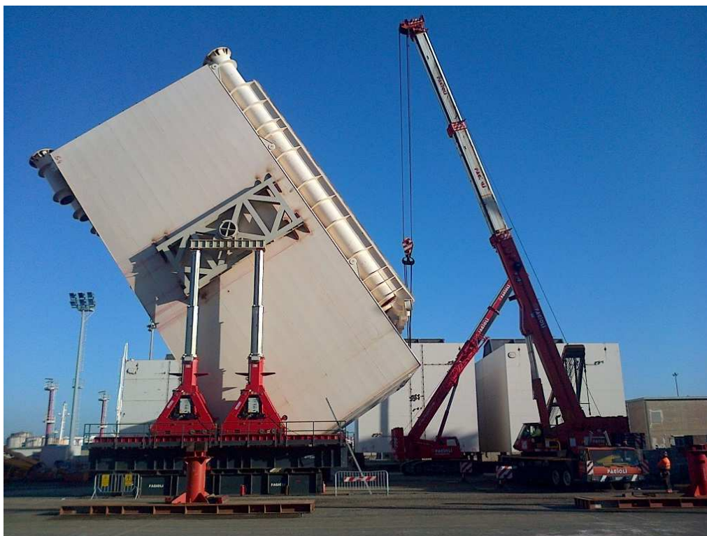
Rotazione del cassone S4 presso il cantiere di Livorno
