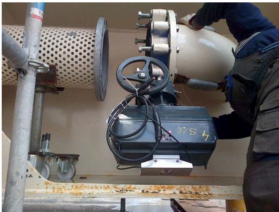
Installazione valvole da 12" sul cassone S12 nel cantiere di Livorno Assemblaggio dei martinetti nel cantiere di Livorno
