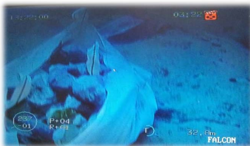
Fasi della raccolta manuale dei detriti di cemento compiute dai divers Micoperi prima di iniziare l'aspirazione mediante sorbona.
