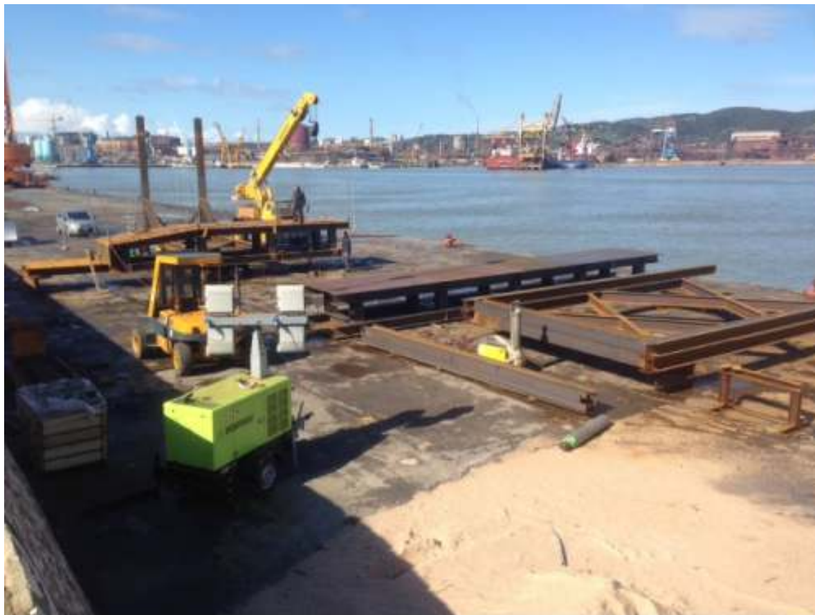
Fabbricazione dei respingenti nel cantiere di Piombino Fabbricazione dei respingenti a bordo della Costa Concordia
