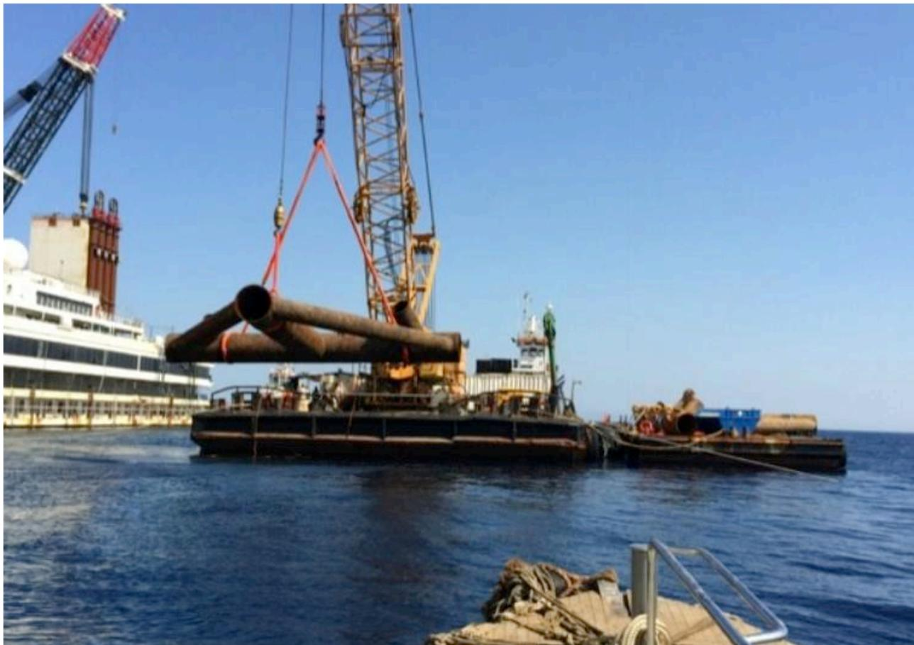
*Sopra: Rimozione tubolari (pull bar) della piattaforma 1*
