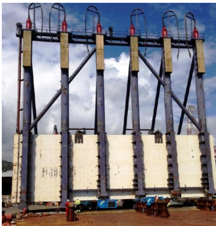
Sopra: rimozione martinetti dalle torri con la HLV Conquest MB1 Sotto: trasferimento del cassone S13 sul pontone Mak a Genova
