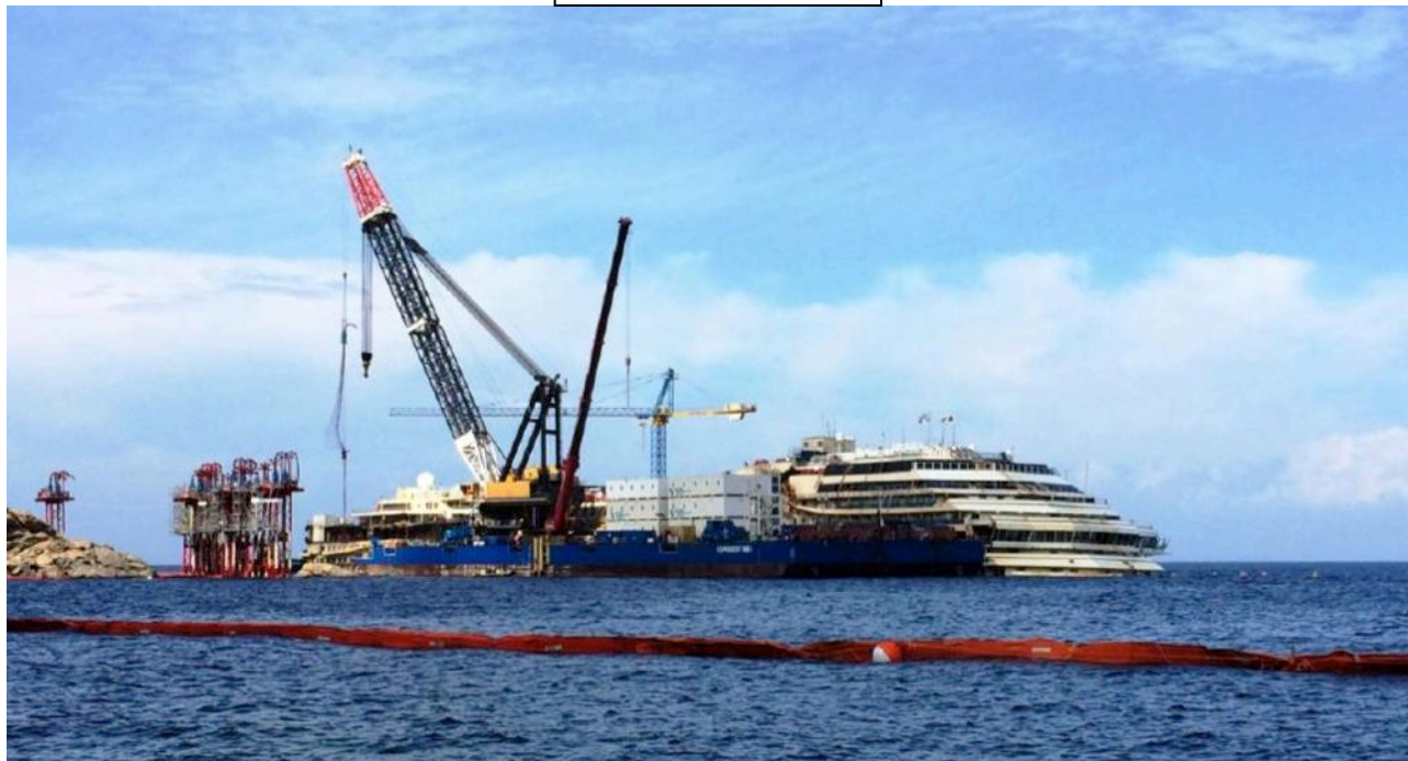
Sopra: rimozione martinetti dalle torri con la HLV Conquest MB1 Sotto: trasferimento del cassone S13 sul pontone Mak a Genova
