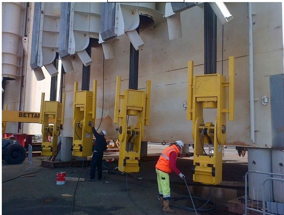
Sopra: Collegamento dei “swivels” ai “link plates” del cassone S11 nel cantiere di Livorno Sotto: Estensioni tubi guida e martinetti installati sui cassoni S11 e S12
